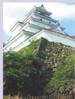
藩生時代に築かれた野面積みの石垣
